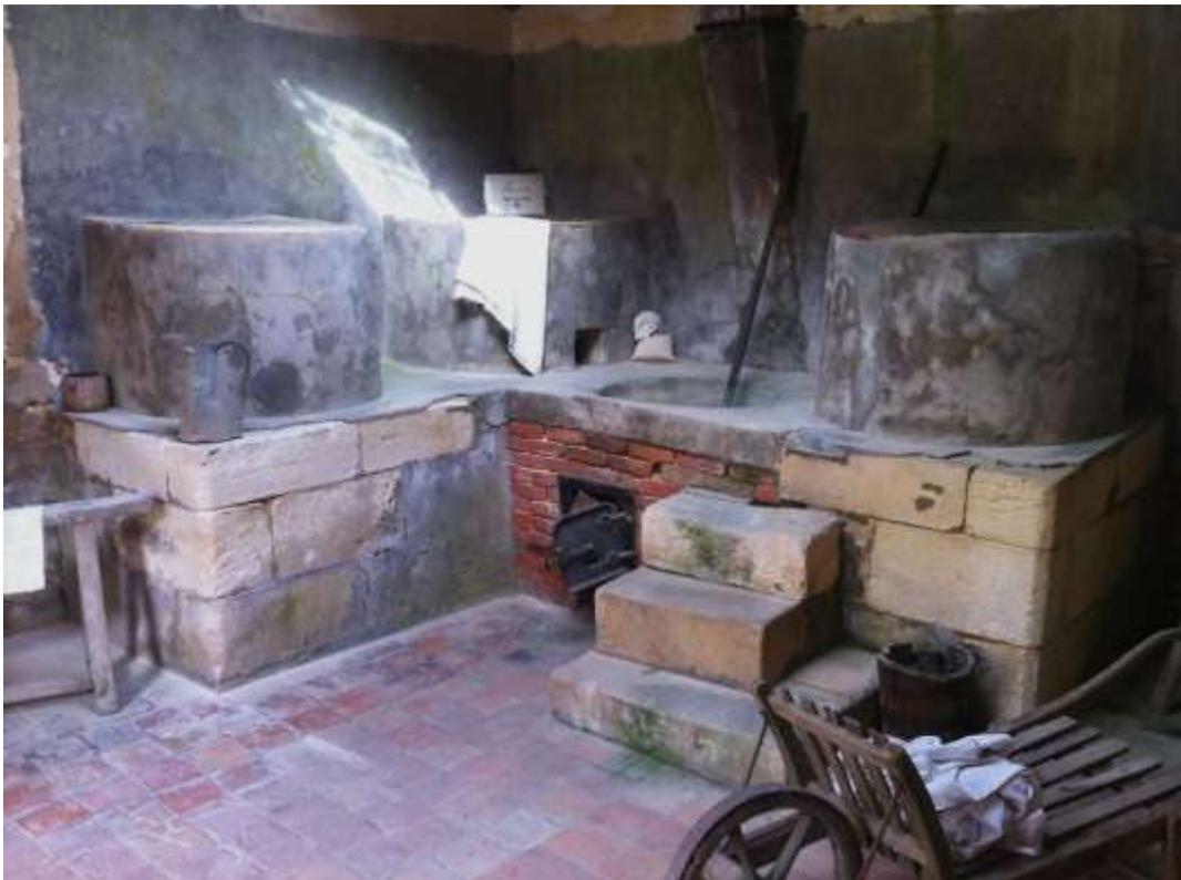
*Fig. 3- Buanderie du château de Panloy (Commune de Port-d'Envaux, Charente-Maritime). Cette belle installation est dans les communs du château, construits dans les années 1870. C'est un exemple précieux d'une buanderie bien datée avec de surcroît, ce qui est exceptionnel, trois « bujours » enserrés chacun dans un revêtement de mortier lissé en surface (Cliché Jean Chapelot).*
