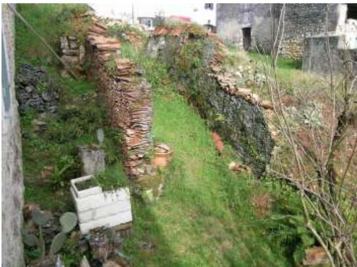
*Fig. 4. Four de bujolier au lieu-dit Les Bujoliers, commune de Saint-Césaire (Charente-Maritime). Ce four, construit en tuiles creuses et carreaux, est implanté dans une forte pente et le long d'une ruelle. En 1882 il est indiqué en ruines. Le relevé donne son état en 1972, quand une partie de sa voûte était encore en place, les deux photos la situation en 2016, alors que les restes de cette voûte sont tombés (Relevé et clichés Jean Chapelot)*
