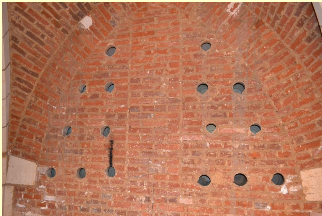
Noyon, caveau de la cathédrale, mur ouest : 16 pots agencés dans le parement de briques
